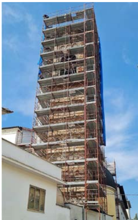
Lavori in corso sul campanile
