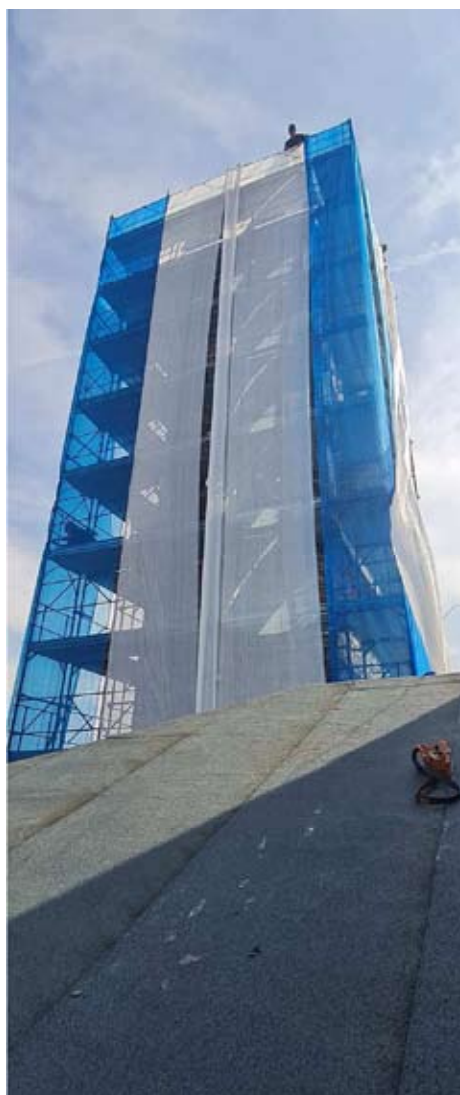
Dal tetto del presbiterio, sembra sorgere un moderno grattacielo
