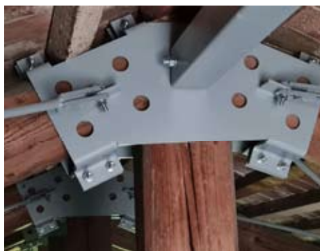
Carpenteria metallica sulle capriate del tetto
