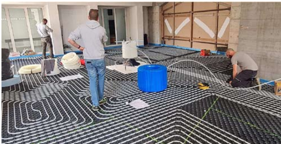
Predisposizione del riscaldamento a pavimento
